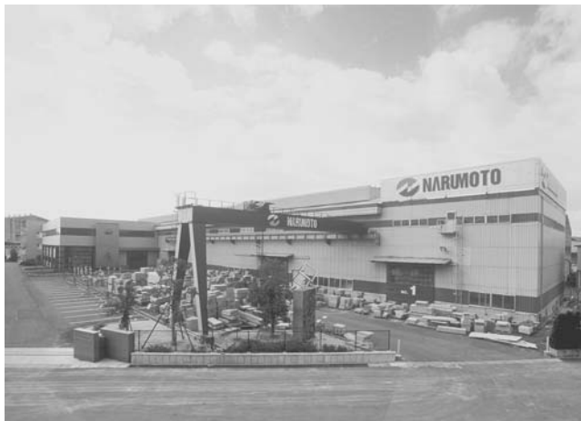
平成元年に建設した本社工場（茂平工業団地内）
