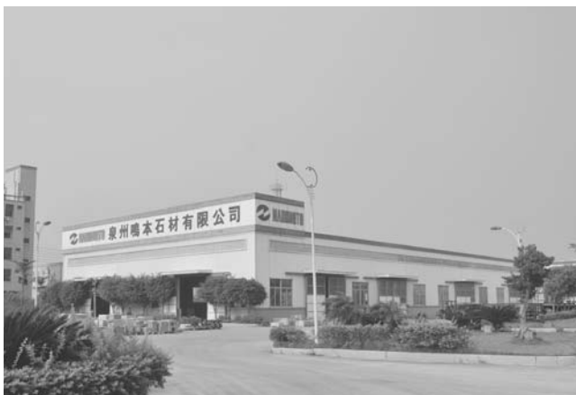
平成 17 年には、中国福建省に独資で「泉州鳴本石材有限公司」を設立した
